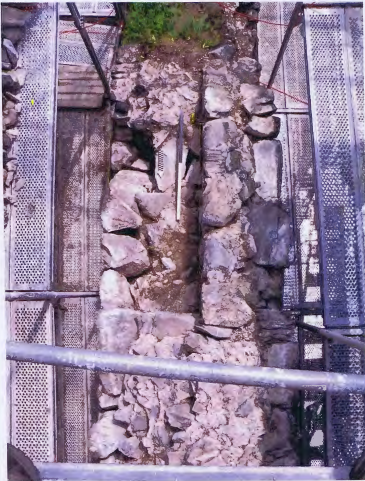
Abb 67 Umfassungsmauer West, Brüstungsmauer Phase 2, Aufsicht
