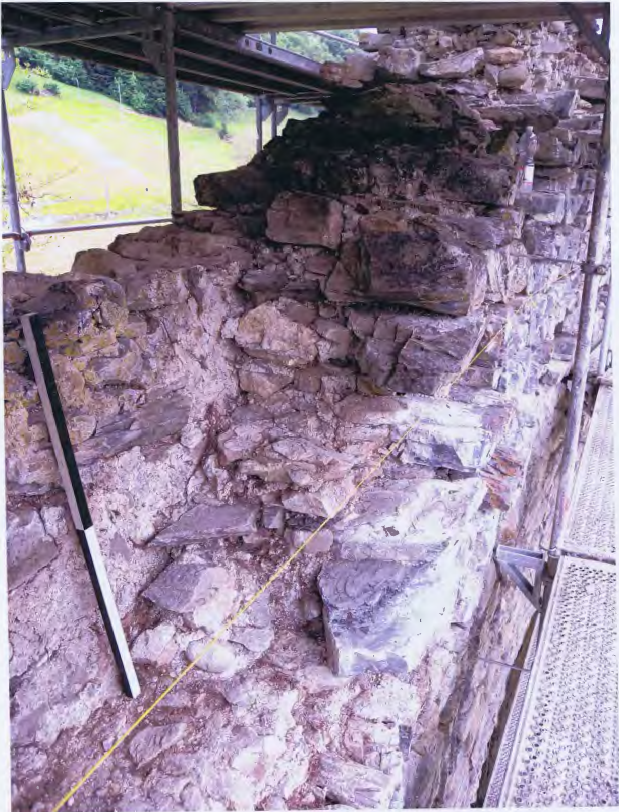
Abb 112 Umfassungsmauer Nord, Aufhöhung Phase 3 auf Wehrgang Phase 2; bei ca. 55 Laufmeter
