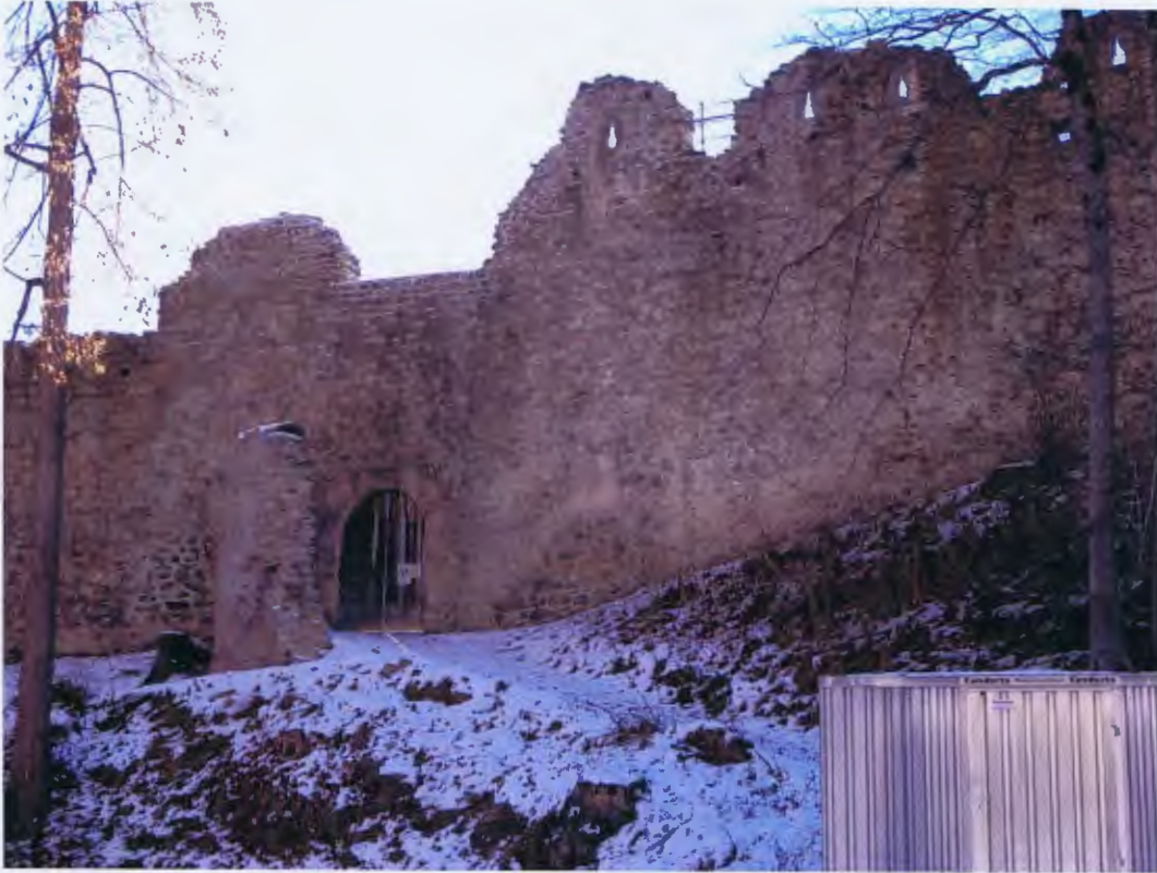
Abb 93 Nachzustand 2013. Zwingermauer an Nordaussenseite, Ansicht aussen
