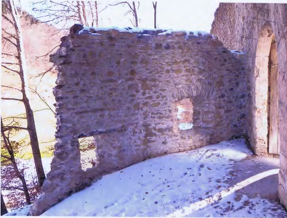
Abb 91 Nachzustand 2013. Zwingermauer an Nordaussenseite, Ansicht aussen
