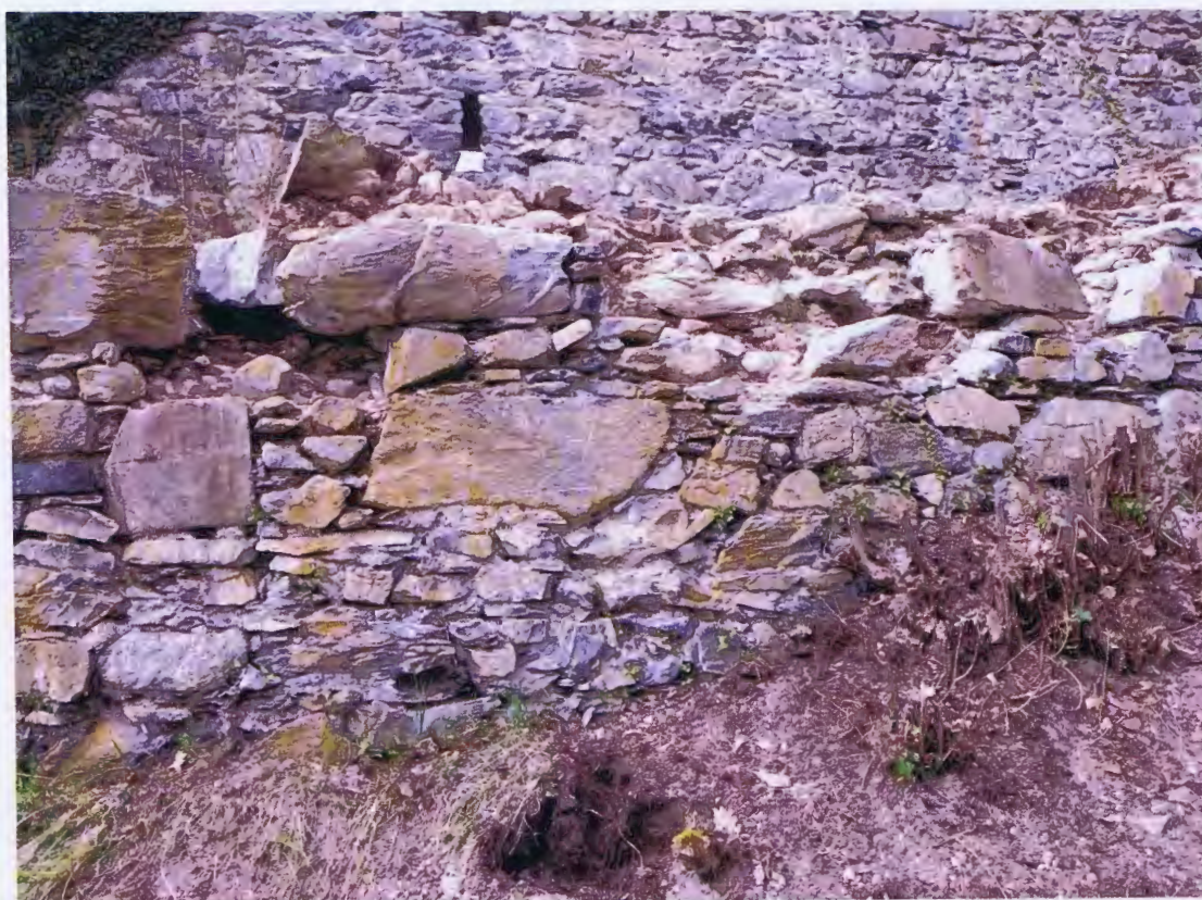
Abb 104 Umfassungsmauer Ost, Restaurierungsetappe 2014. Ansicht Aussenseite
