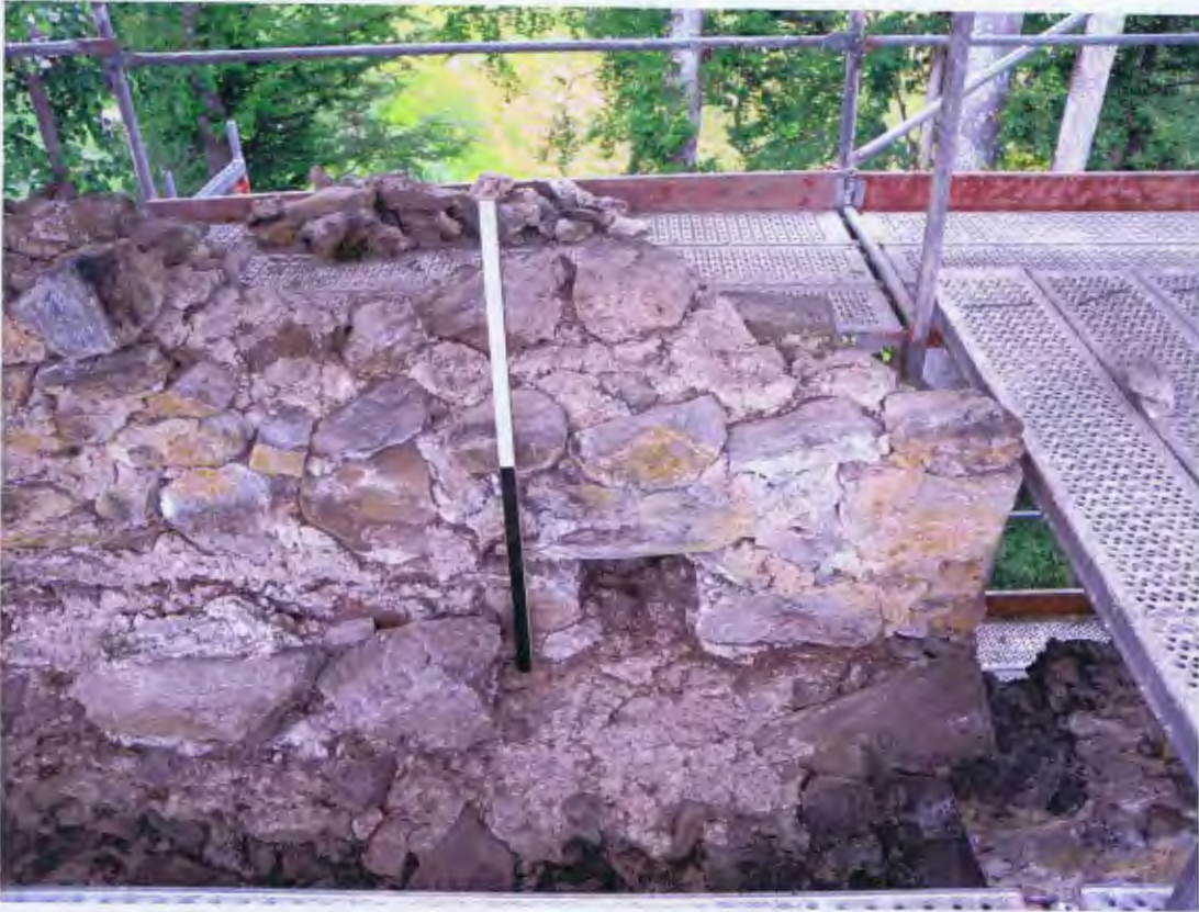
Abb 115 Umfassungsmauer Nord, Brüstungsmauer Phase 2, Innenseite
