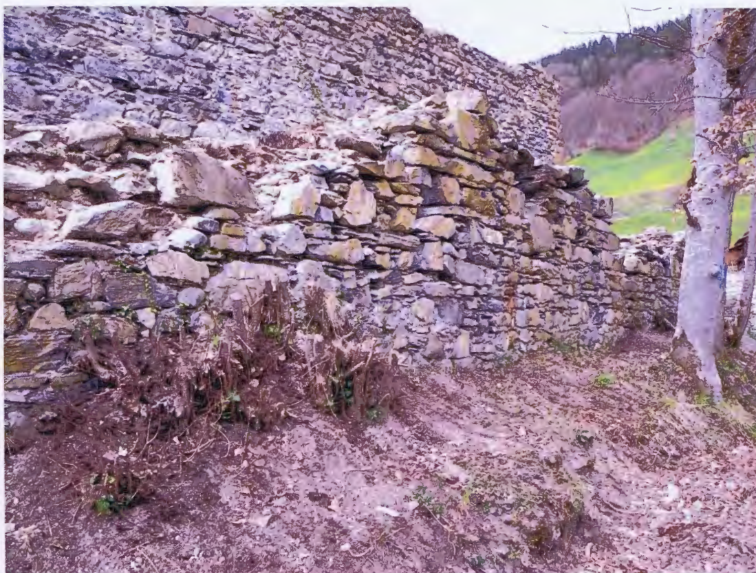
Abb 103 Umfassungsmauer Ost, Restaurierungsetappe 2014. Ansicht Aussenseite
