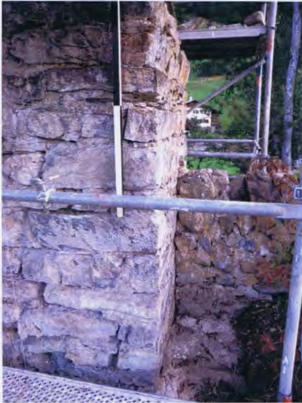
Abb 77 Umfassung Nord, Innenseite Aufstehender Pfeiler Phase 1 und Brüstungsmauer Phase 2
