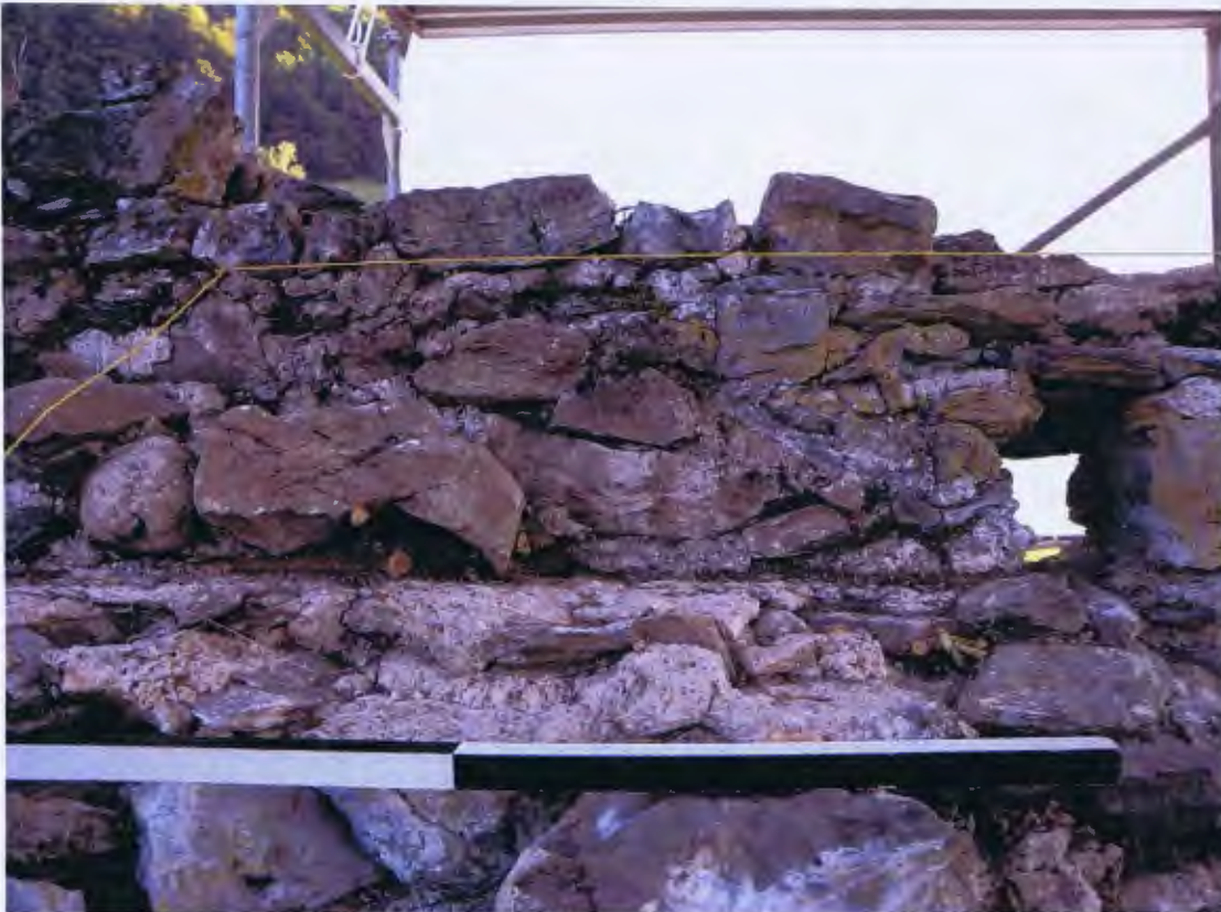
Abb 83 Umfassung Nord, Abschnitt bei Loch 2013. Wehrgang mit Brüstungsmauer
