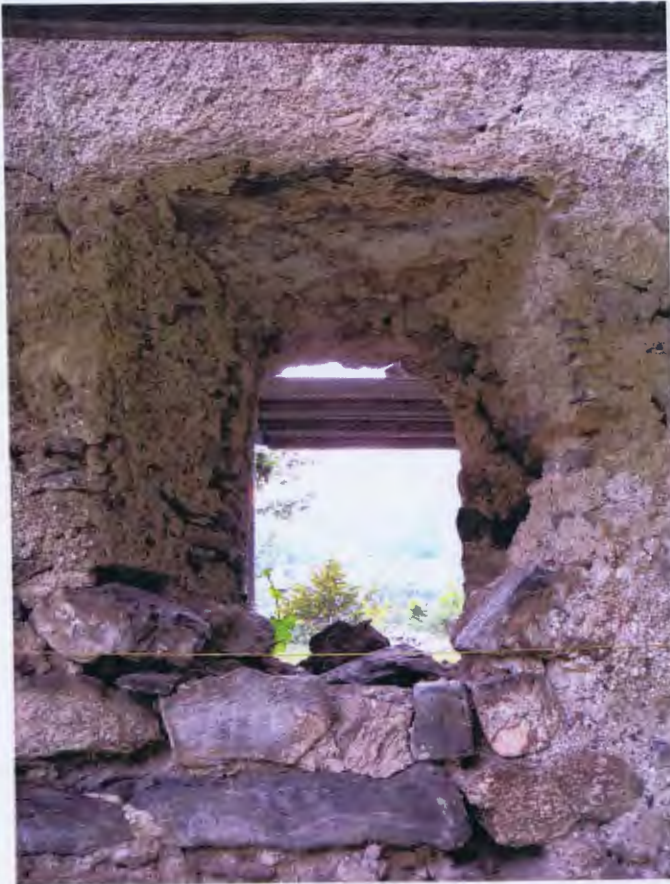
Abb 119 Umfassungsmauer Nord, Fenster zu Phase 3, Aussenansicht.
