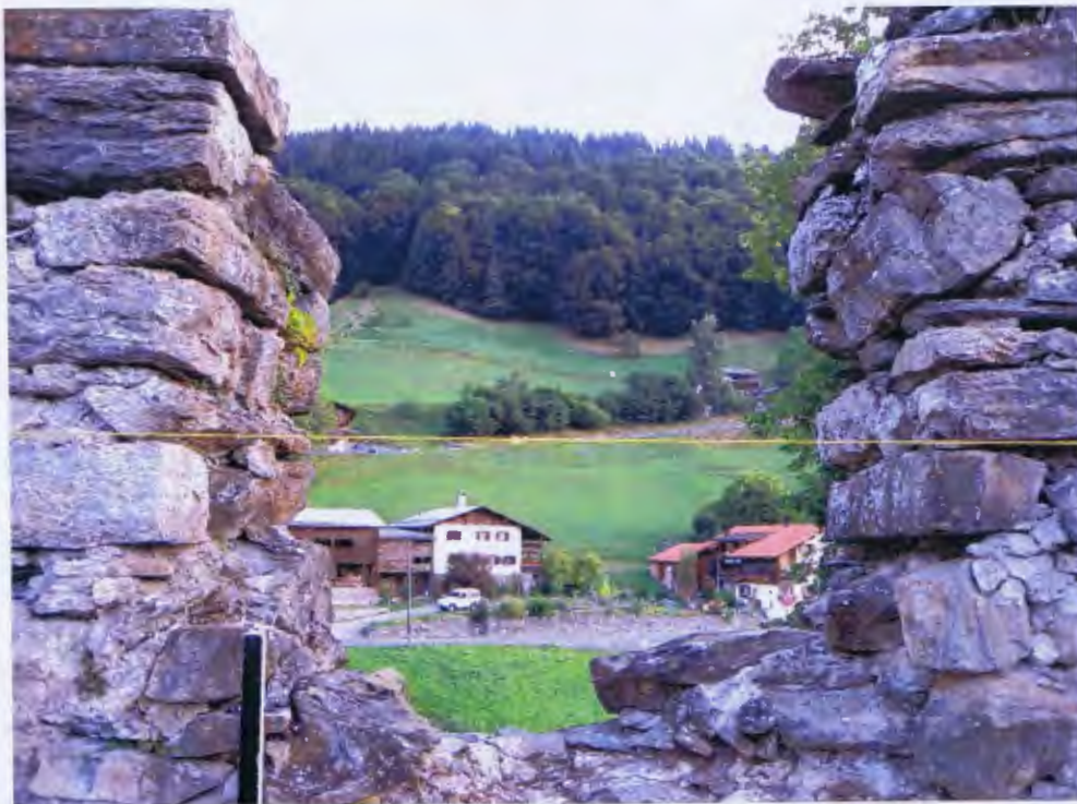
Abb 73 Umfassung Nord, Innenseite 2013. Zinnenluke in Brüstungsmauer Phase 2
