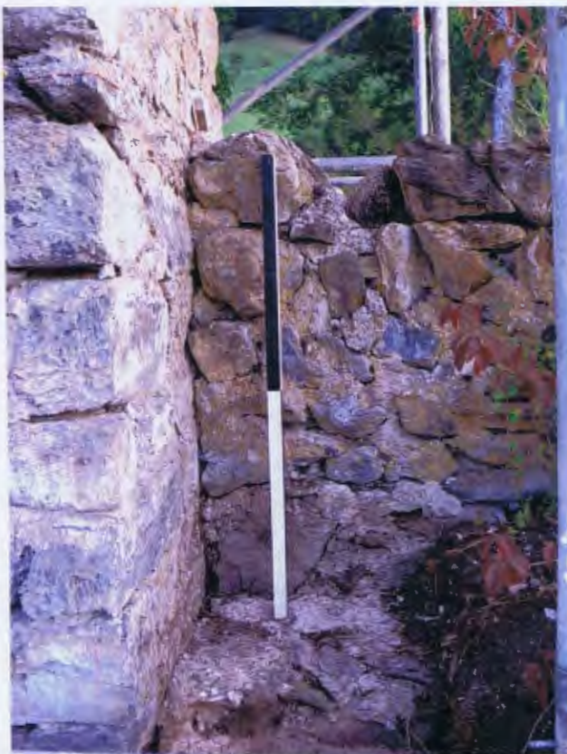
Abb 78 Umfassung Nord, Innenseite. Pfeiler Phase 1 und Anschluss Brüstungsmauer Phase 2
