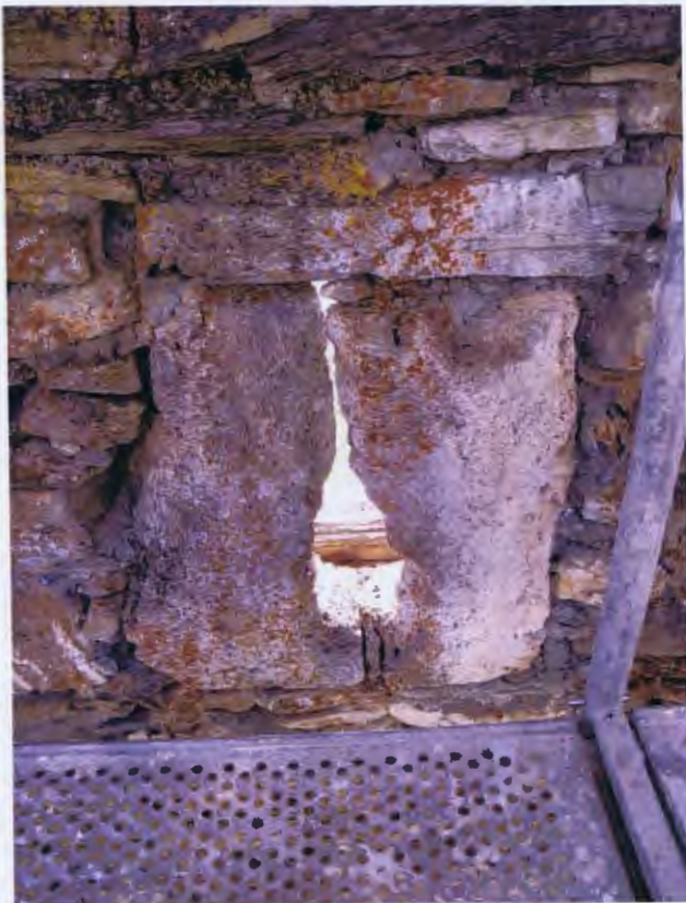
Abb 98 Umfassungsmauer Nord, Brüstungsmauer mit Schlüssellochscharte Phase 2
