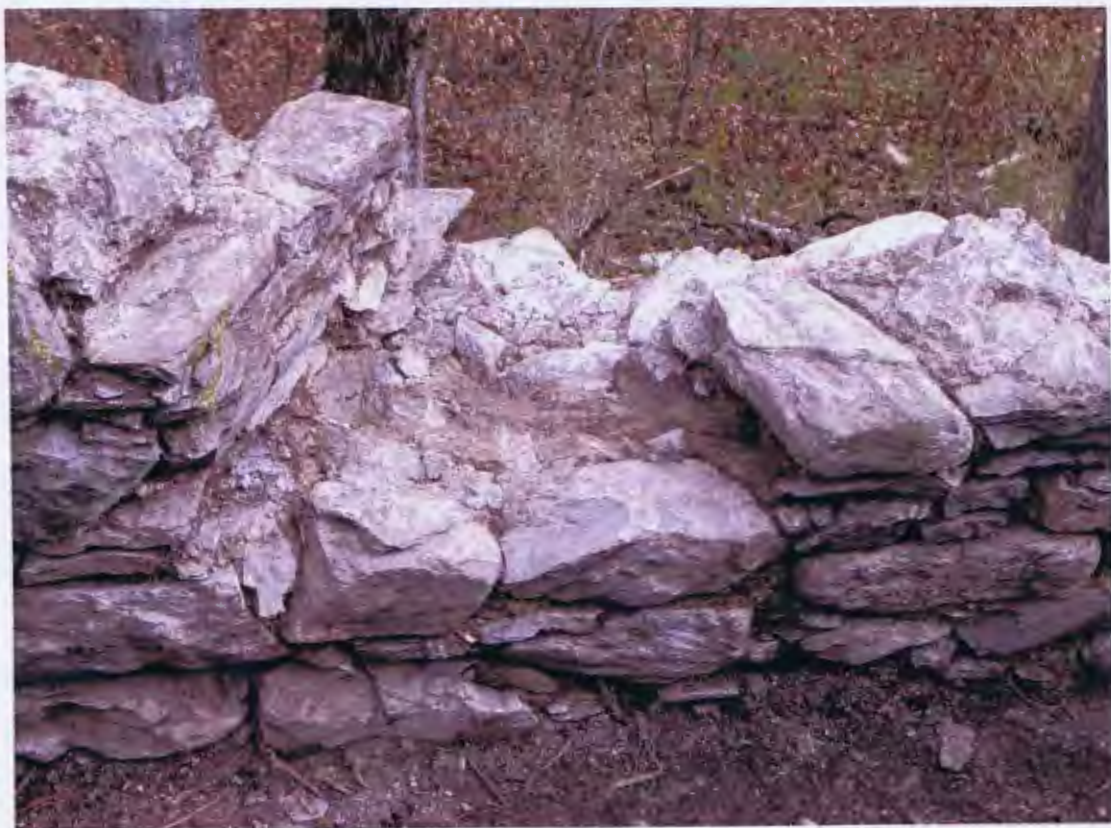
Abb 106 Umfassungsmauer Ost, Restaurierungsetappe 2014. Scharte freigelegt.
