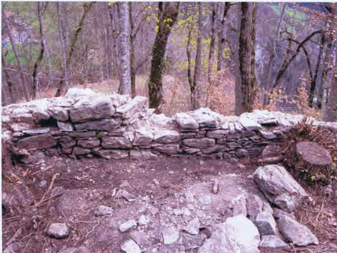
Abb 105 Umfassungsmauer Ost, Restaurierungsetappe 2014. Scharte freigelegt
