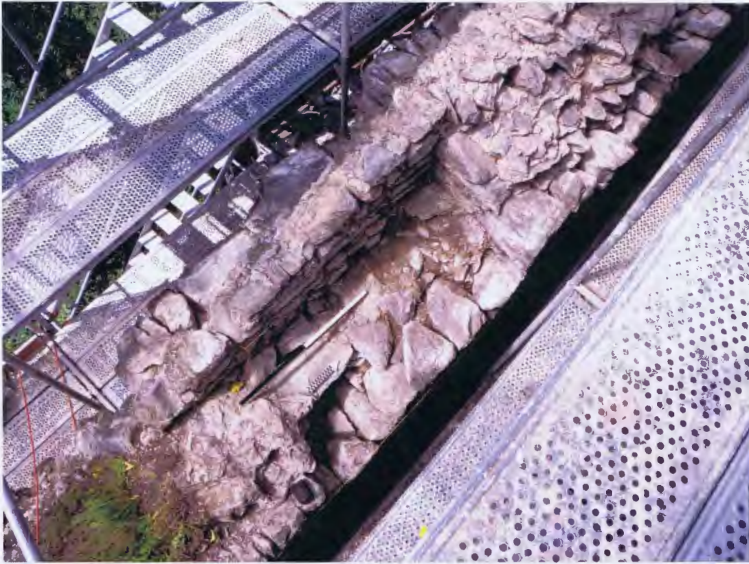
Abb 62 Umfassungsmauer West, Bauuntersuchung 2012. Brüstungsmauer Phase 2, Aufsicht
