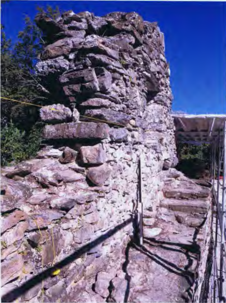
Abb 70 Umfassung Nord, Innenseite 2013. Wehrgang und Brüstungsmauer Phase 2
