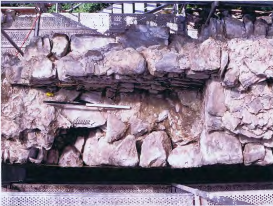
Abb 66 Umfassungsmauer West, Brüstungsmauer Phase 2, Aufsicht
