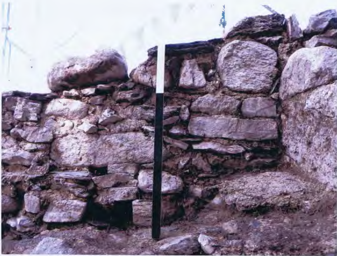
Abb 64 Umfassungsmauer West, . Anschluss Brüstung Phase 2 an Stufe Phase 1
