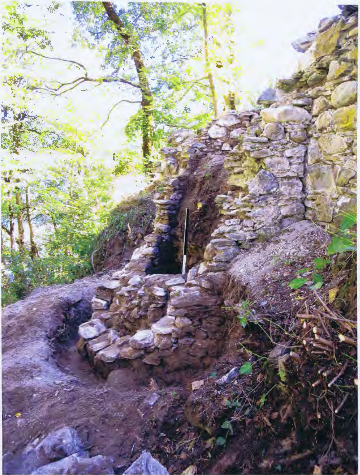
Abb 84 Bastion an E-Aussenseite, durch ADG freigelegt.
