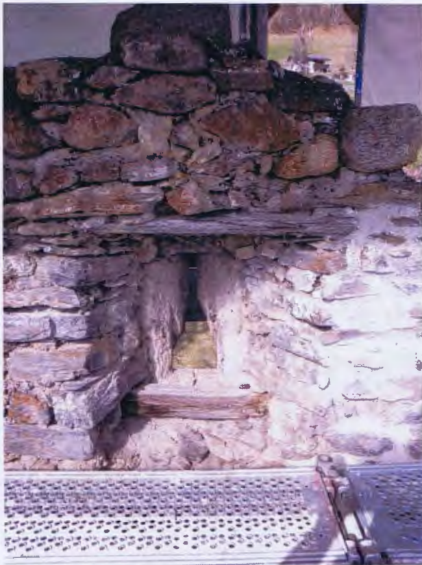
Abb 95 Umfassungsmauer Nord, Restaurierungsetappe 2014, Brüstungsmauer mit Scharte
