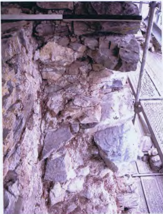
Abb 114 Umfassungsmauer Nord, Aufhöhung Phase 3 auf Wehrgang Phase 2
