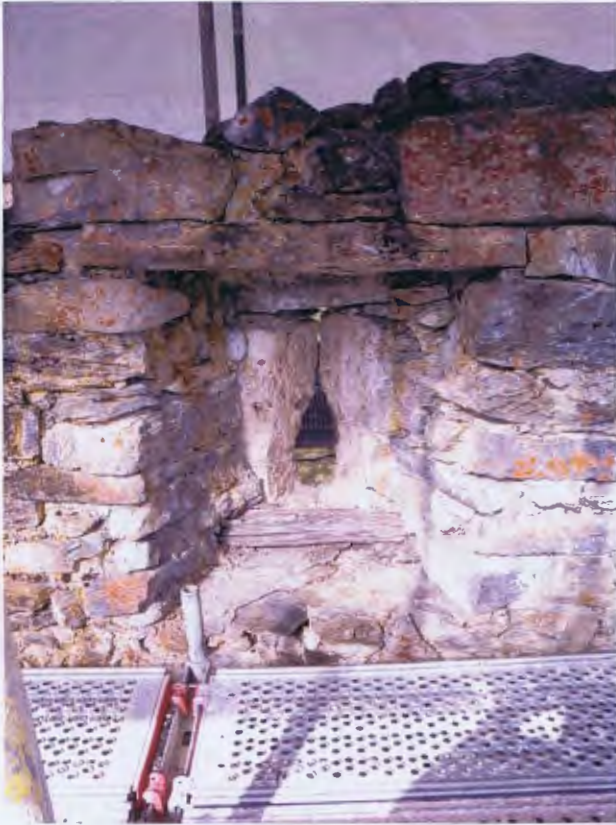
Abb 97 Umfassungsmauer Nord. Brüstungsmauer mit Schlüssellochscharte Phase 2
