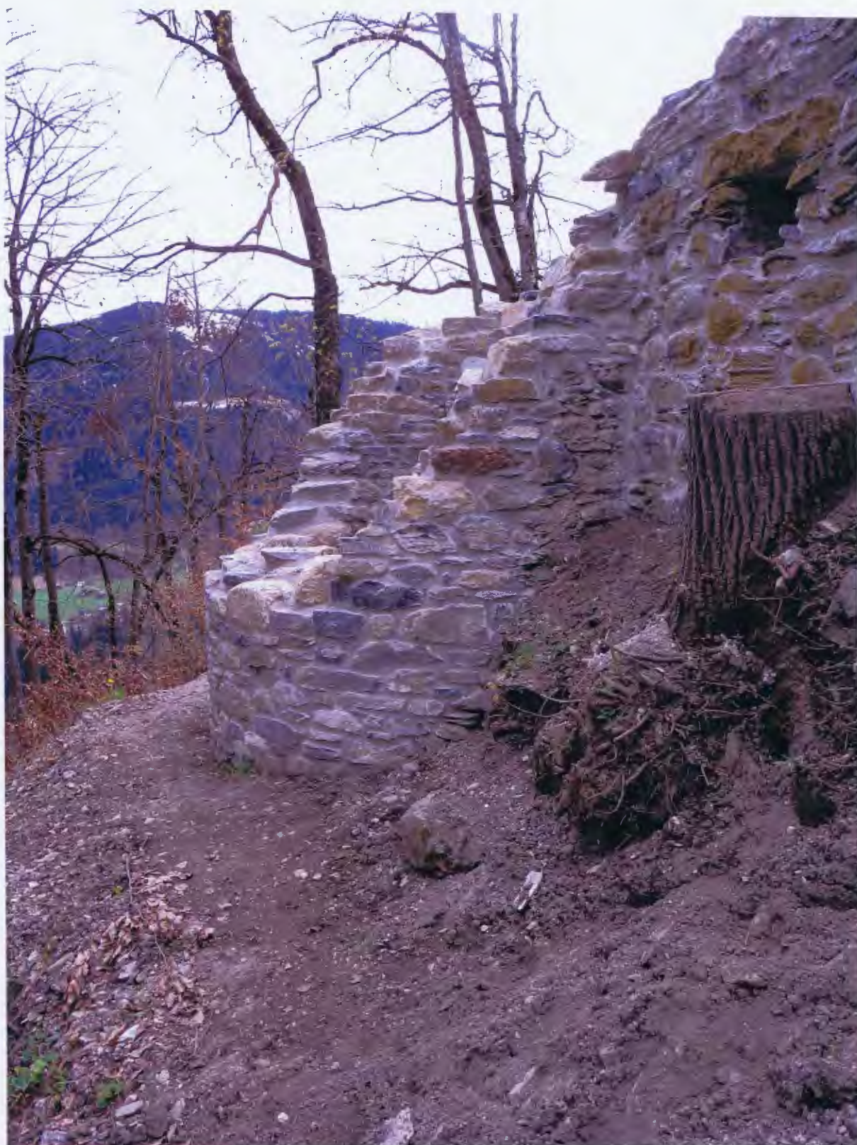
Abb 102 Umfassungsmauer Ost, Restaurierungsetappe 2014. Bastion, Nachzustand Frühjahr 2014
