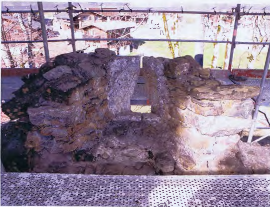
Abb 99 Umfassungsmauer Nord, Brüstungsmauer mit Schlüssellochscharte Phase 2
