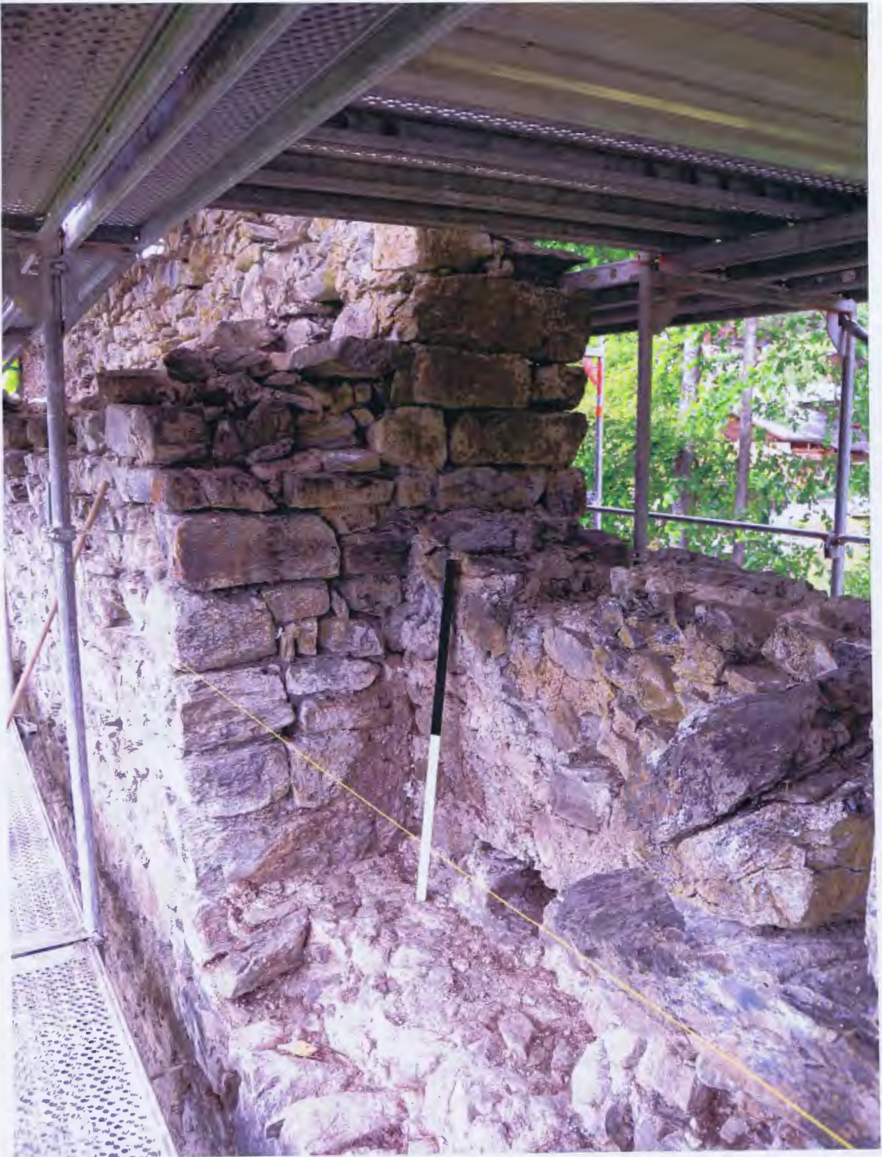
Abb 109 Umfassungsmauer Nord, Stufe mit Eckverband Phase 1 und Brüstungsmauer Phase 2
