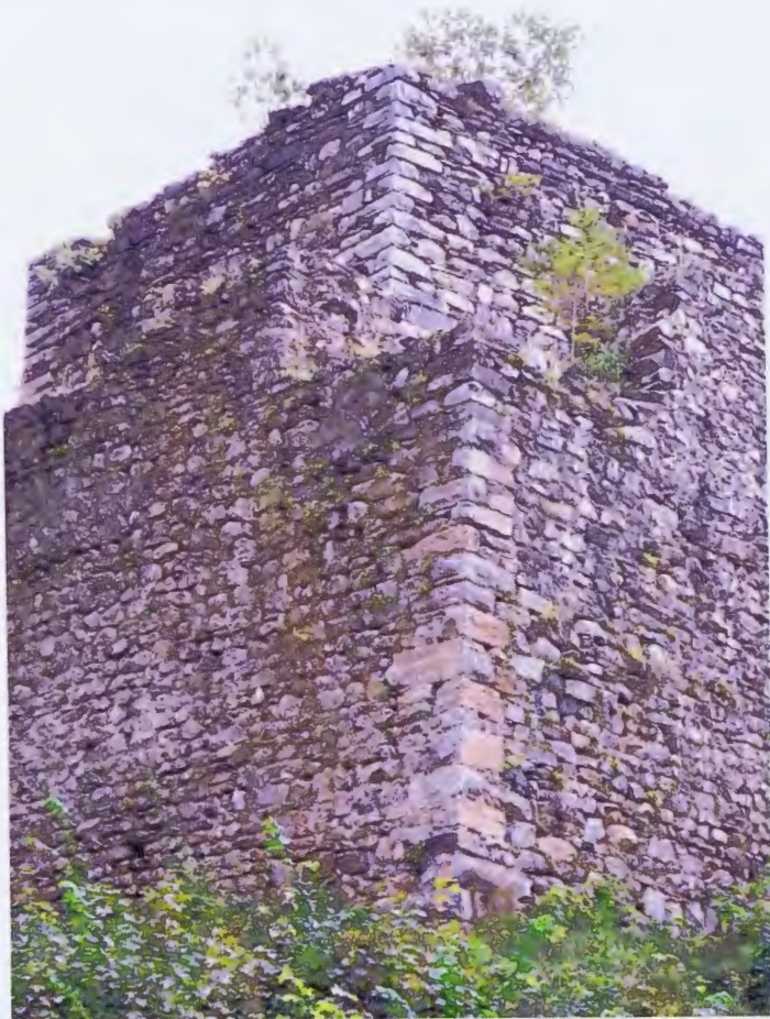
Abb. 59 NW- Aussenseite der Anlage, Vorzustand
