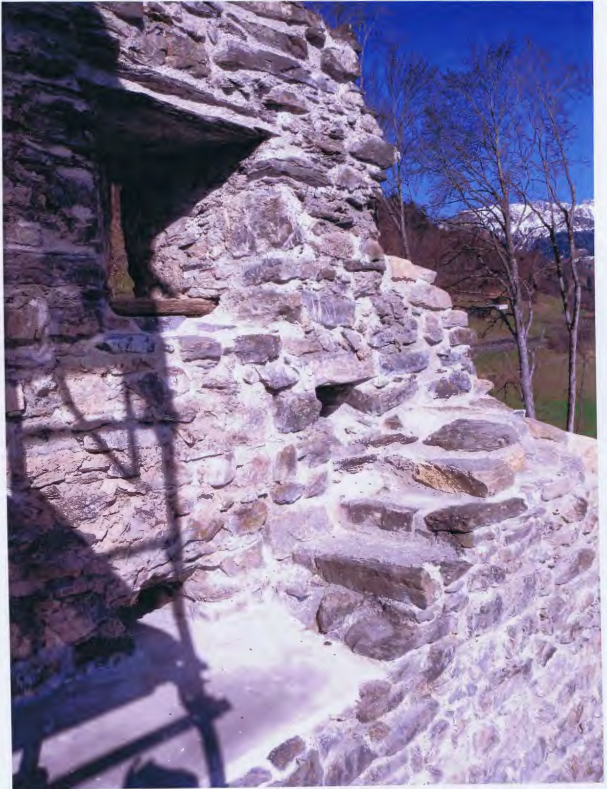
Abb 101 Umfassungsmauer Nord, Restaurierungsetappe 2014. Wehrgang mit Treppenstufen
