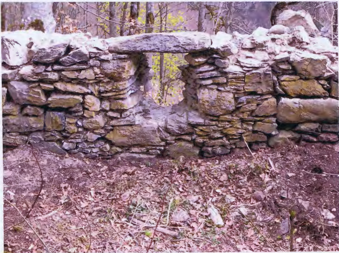
Abb 108 Umfassungsmauer Ost, Restaurierungsetappe 2014. Erhaltene Scharte, Innenseite
