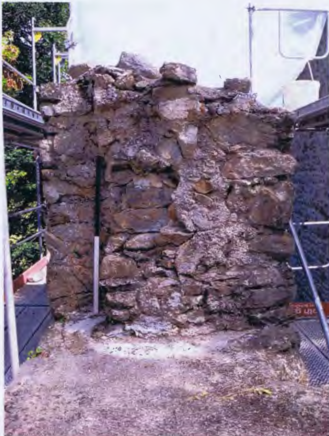
Abb 69 Umfassungsmauer West, . Aufstehender Pfeiler Phase 1, über N-Umfassung
