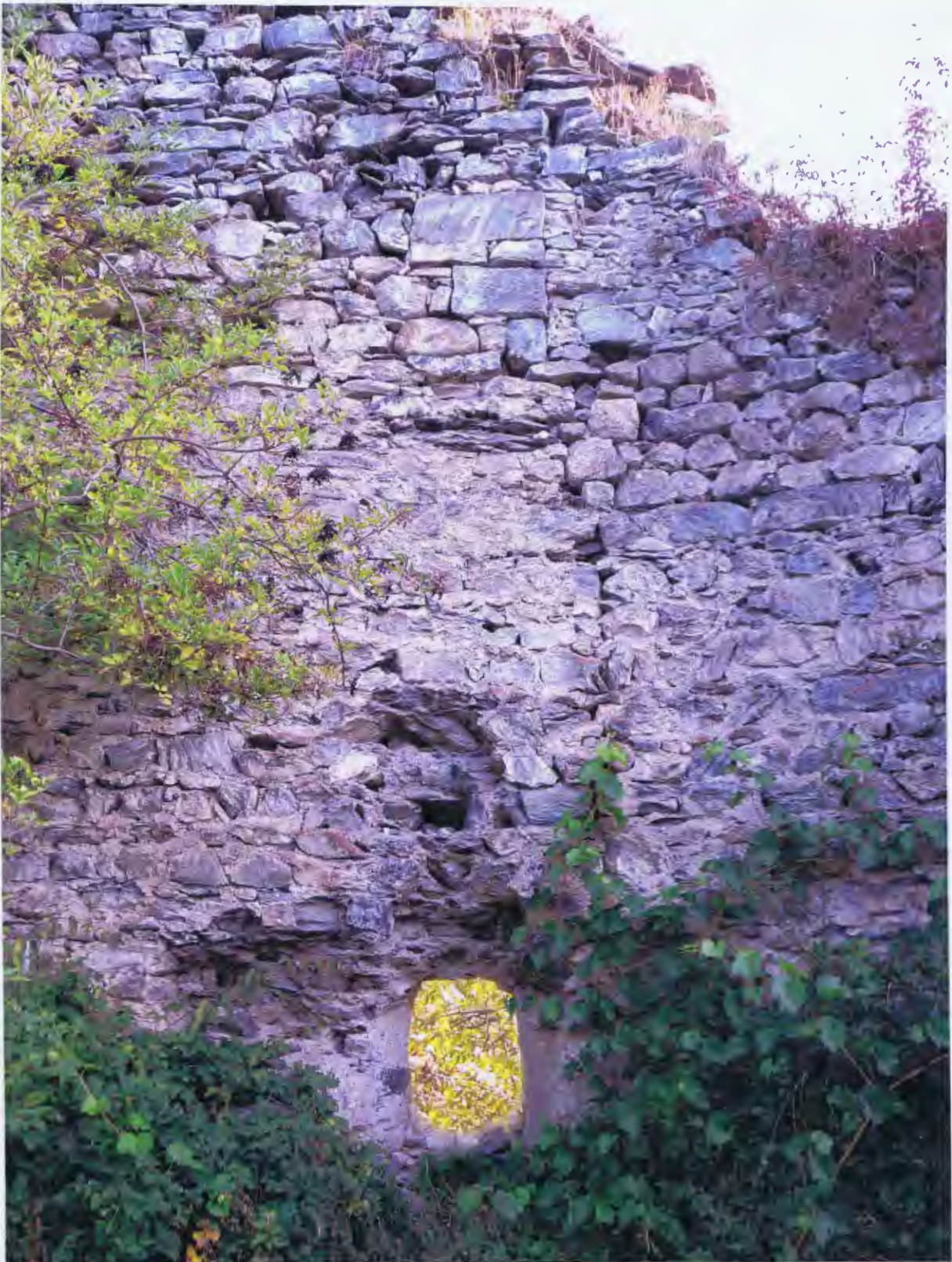
Abb 117 Umfassungsmauer Nord, Fenster zu Phase 3
