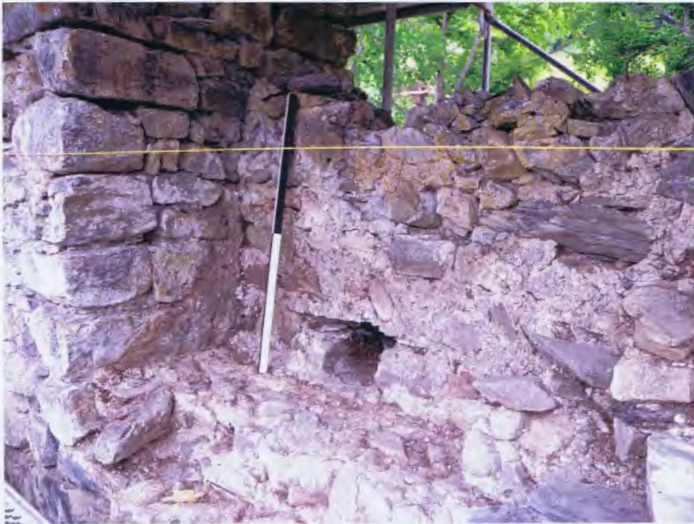
Abb 110 Stufe mit Eckverband Phase 1 und daran anschliessende Brüstungsmauer Phase 2
