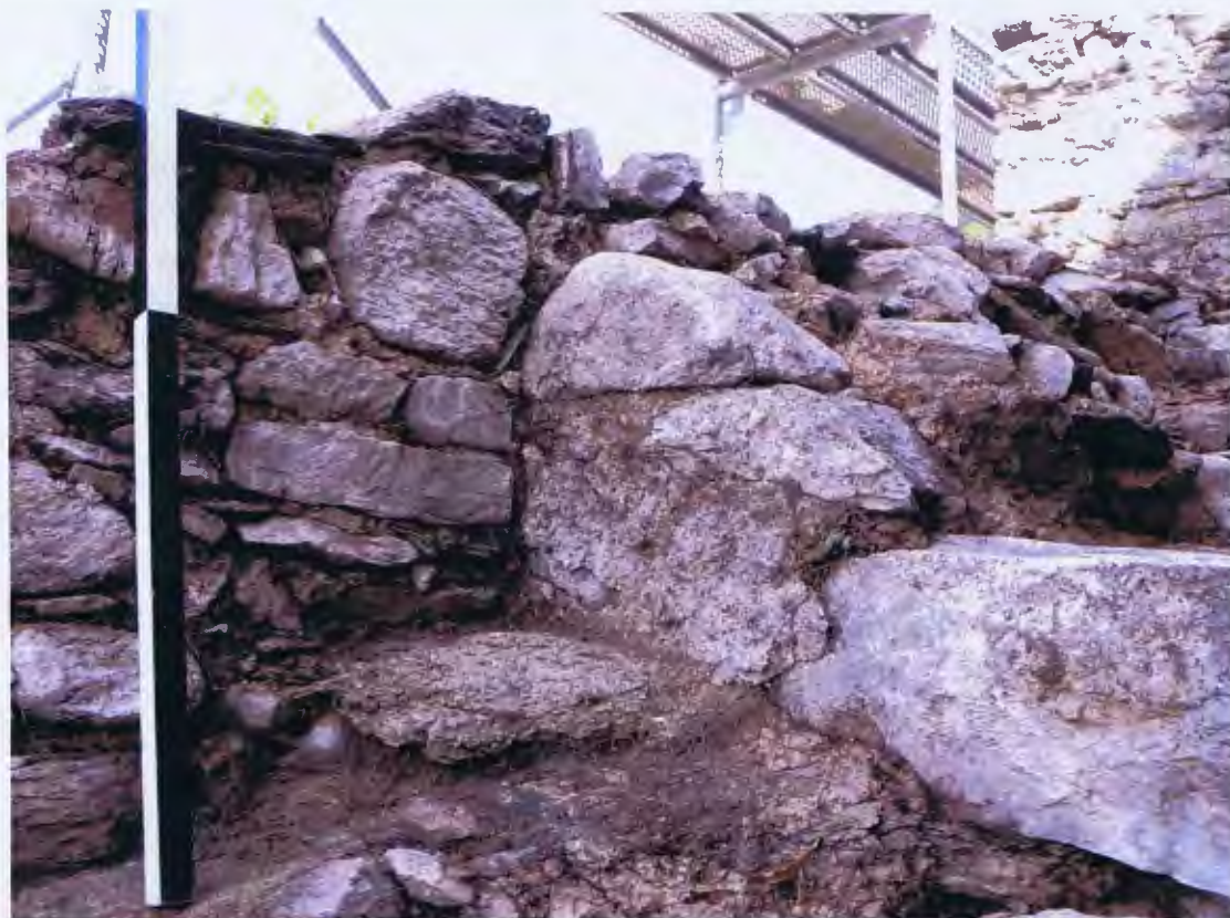
Abb 65 Umfassungsmauer West, Bauuntersuchung 2012. Rest Möbo Phase 2
