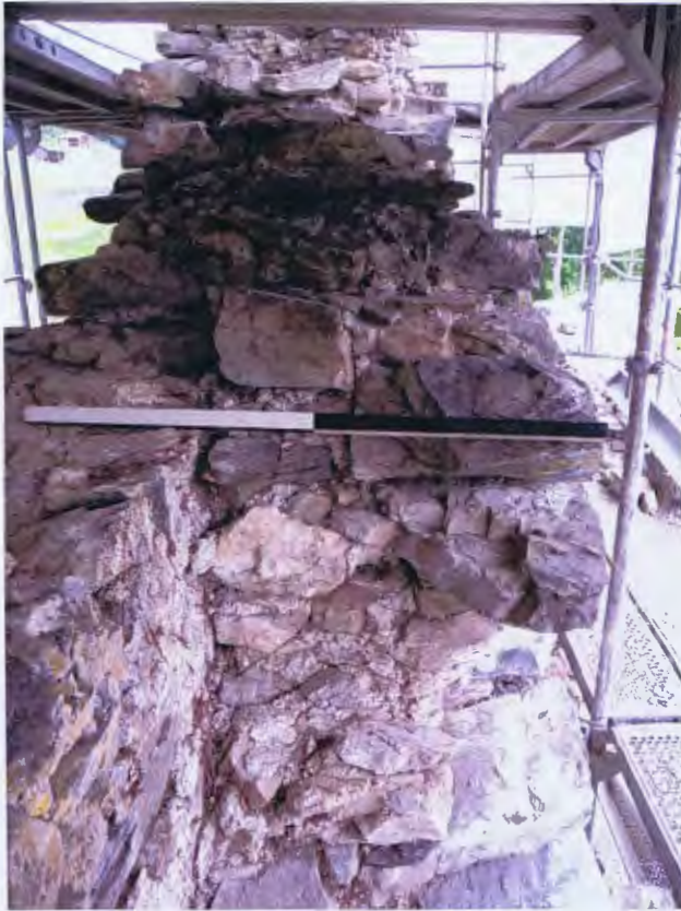
Abb 113 Umfassungsmauer Nord, Aufhöhung Phase 3 über Wehrgang Phase 2
