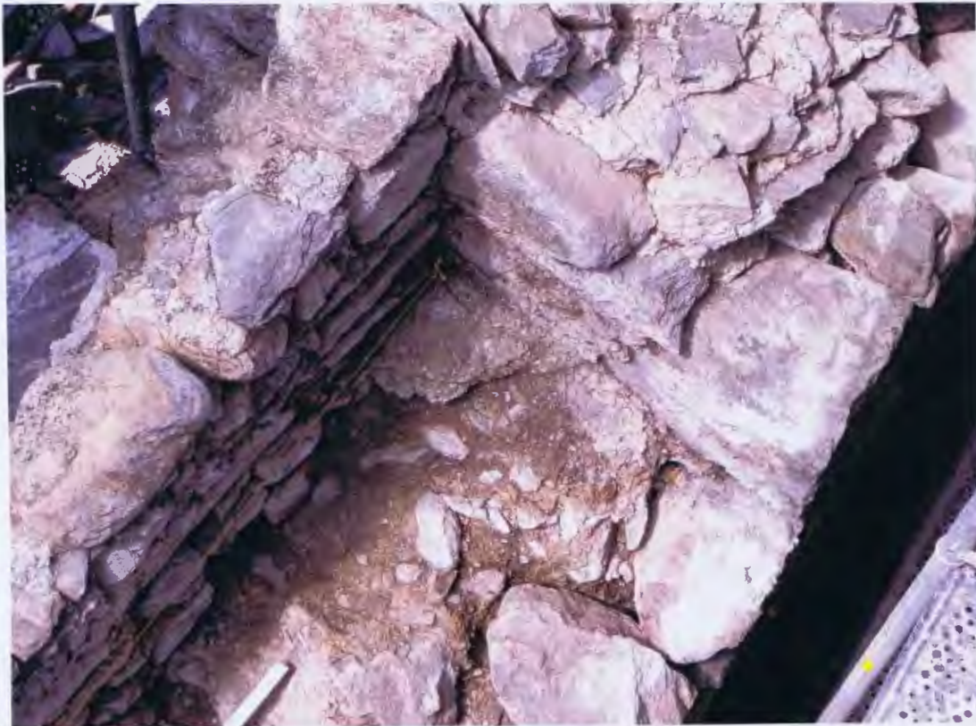
Abb 63 Umfassungsmauer West, Anschluss Brüstung Phase 2 an Stufe Phase 1
