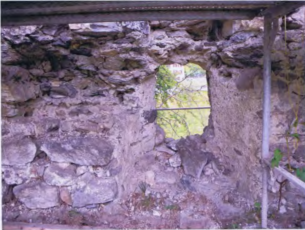
Abb 118 Umfassungsmauer Nord, Fenster zu Phase 3, Innenansicht
