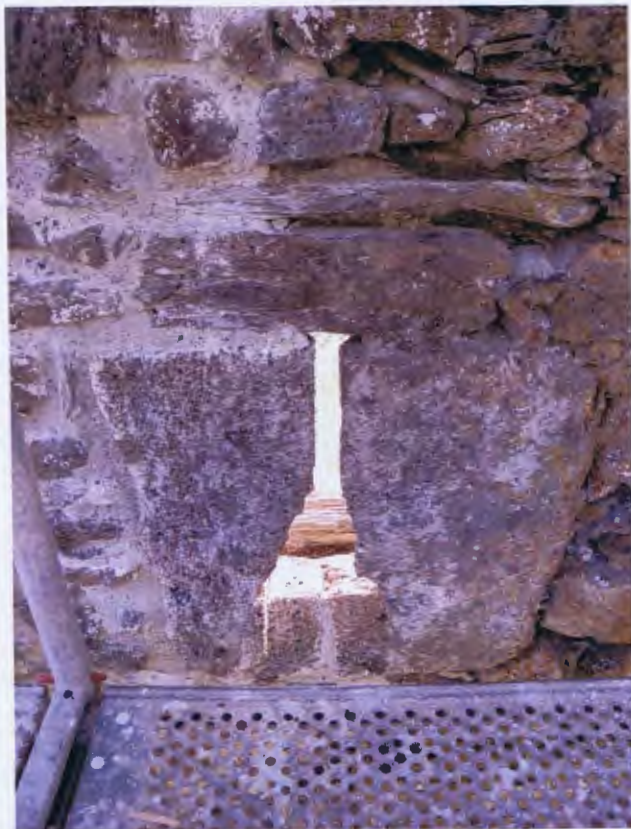
Abb 96 Umfassungsmauer Nord, Brüstungsmauer mit Schlüssellochscharte Phase 2
