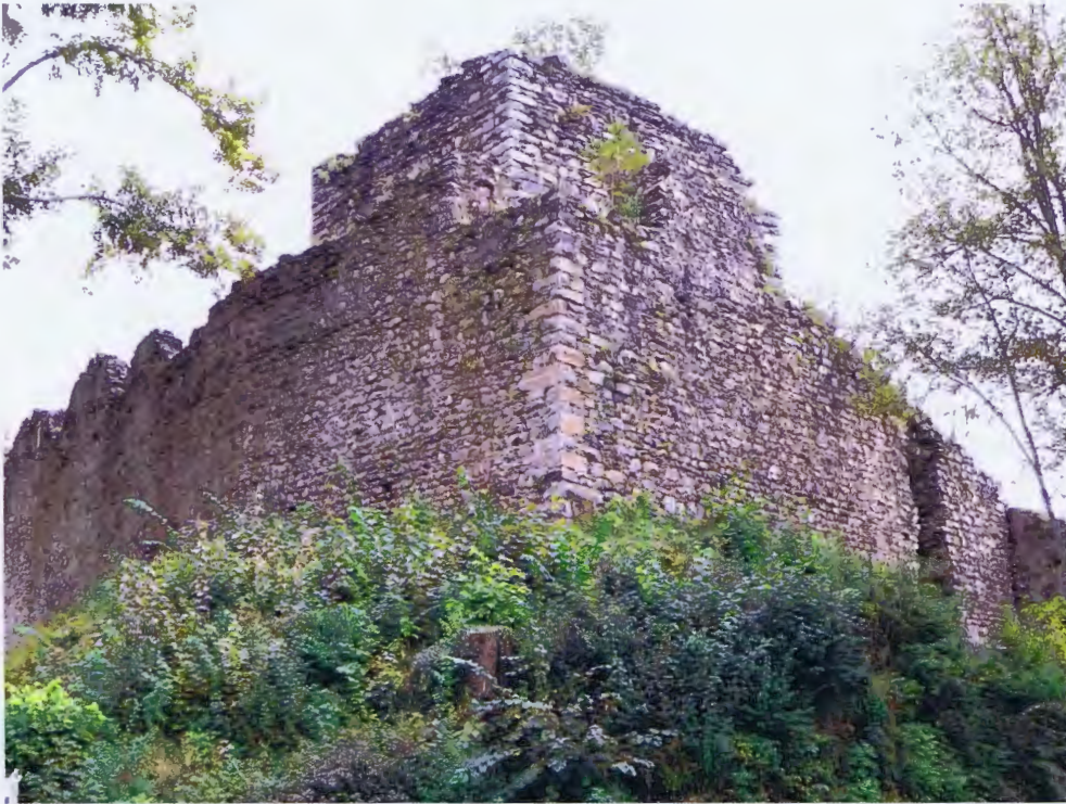
Abb. 58 NW- Aussenseite der Anlage, Vorzustand
