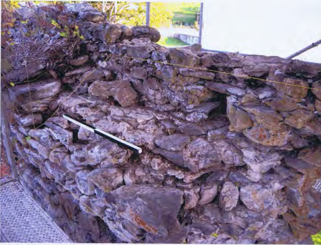
Abb 82 Umfassung Nord, Abschnitt bei Loch 2013. Wehrgang mit Brüstungsmauer
