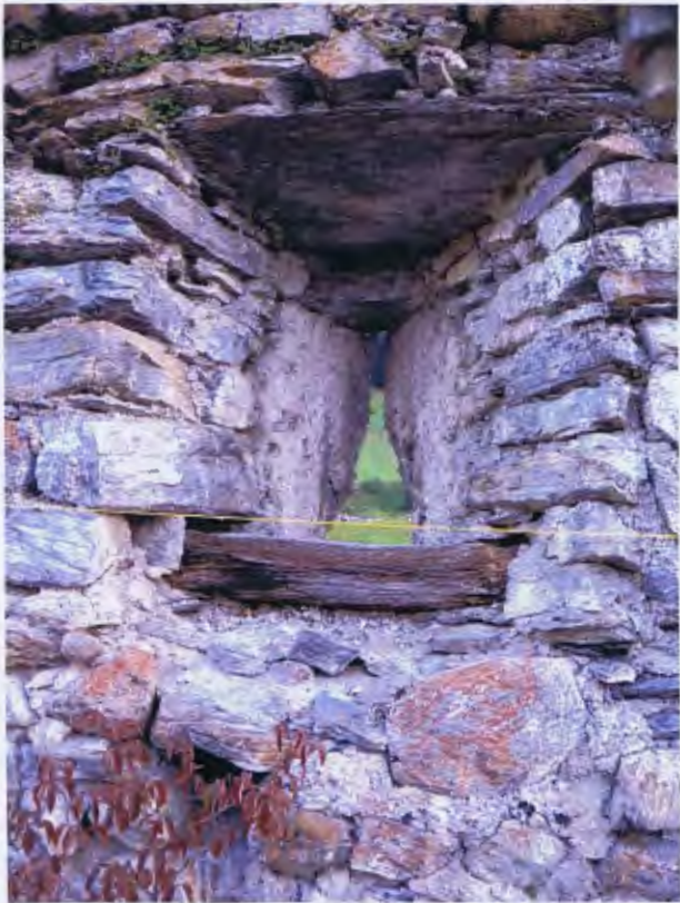
Abb 74 Umfassung Nord, Innenseite 2013. Schlüssellochscharte in Brüstungsmauer
