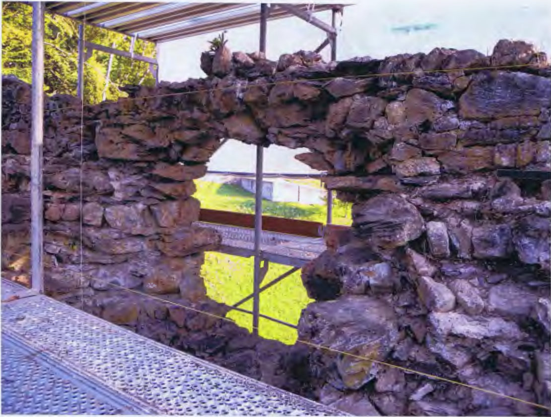
Abb 80 Umfassung Nord, Abschnitt bei Loch 2013. Wehrgang mit Brüstungsmauer
