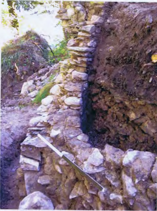
Abb 87 Bastion an E-Aussenseite, durch ADG freigelegt.
