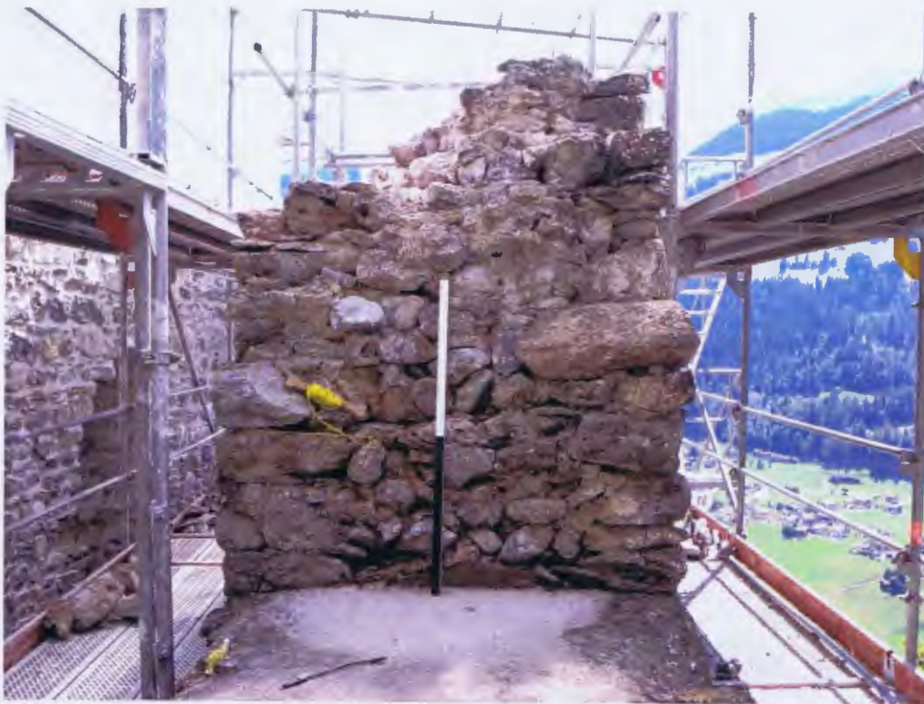
Abb 68 Umfassungsmauer West, . Aufstehender Pfeiler Phase 1
