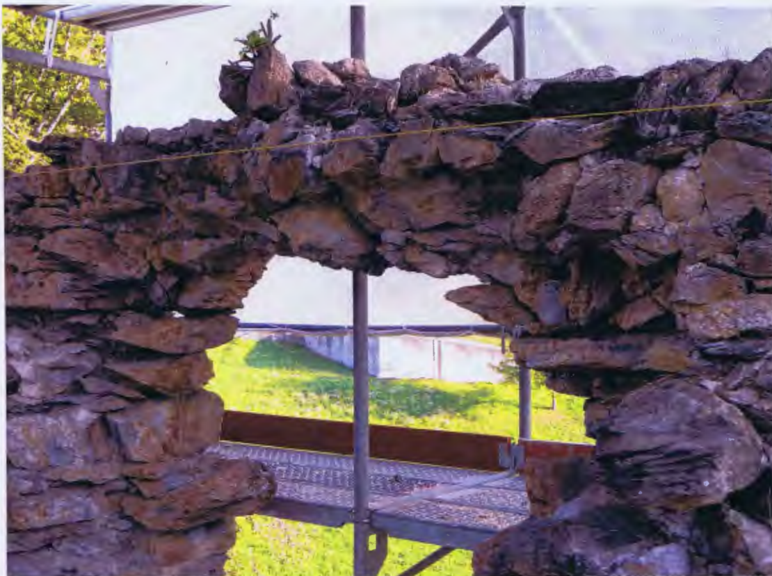
Abb 81 Umfassung Nord, Abschnitt bei Loch 2013. Wehrgang mit Brüstungsmauer
