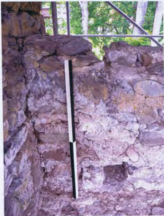
Abb 111 Umfassungsmauer Nord, Anschluss Brüstung Phase 2 an Stufe der Phase 1
