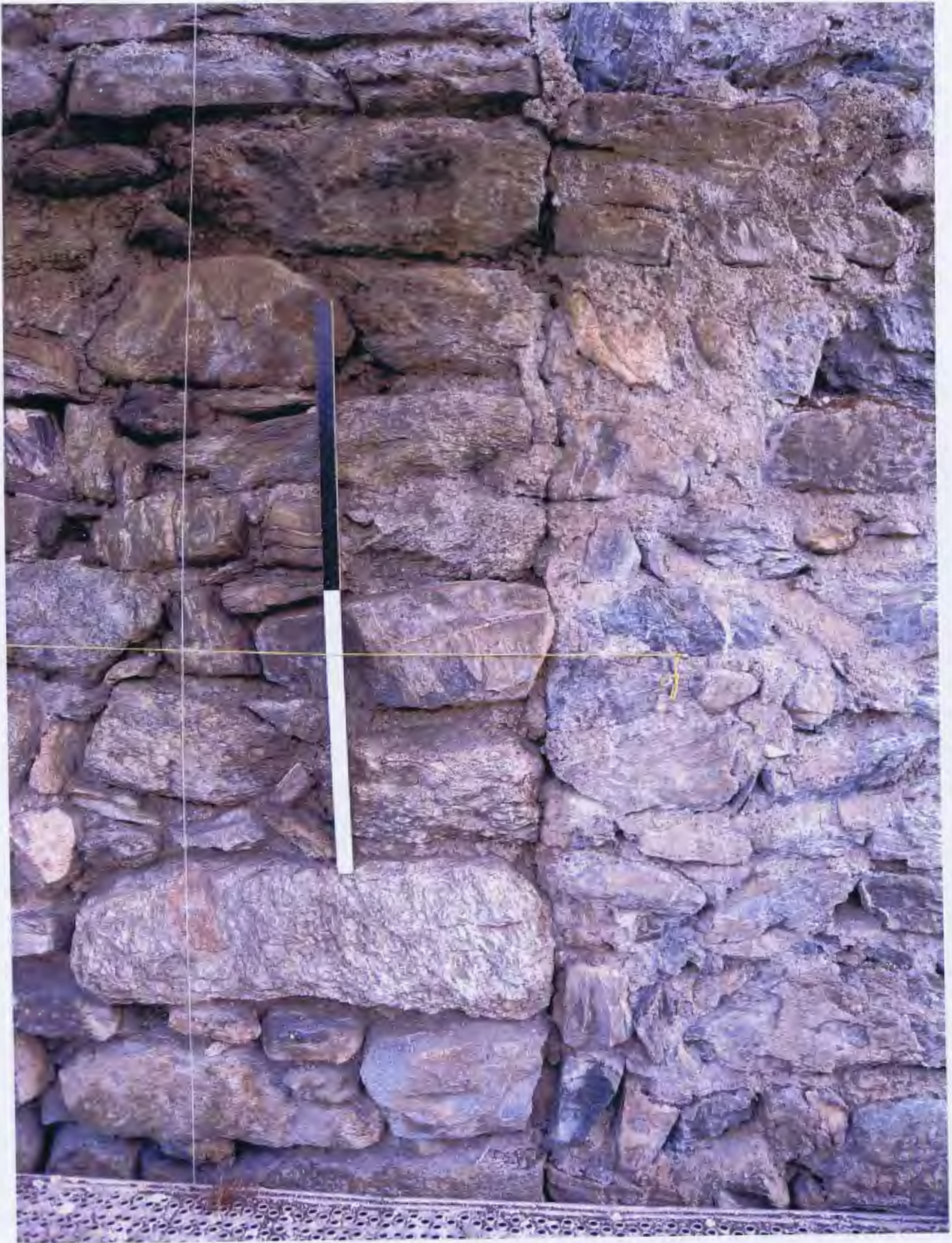
Abb 76 Umfassung Nord, Innenseite 2013. Vertikale Baunaht im Ostteil
