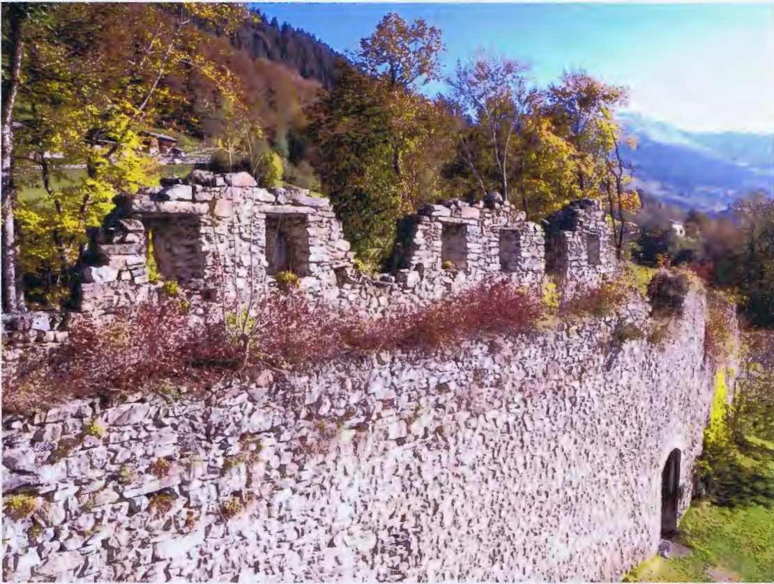
Abb 60 Umfassungsmauer Nord, Innenseite, Vorzustand. Ostteil des Burghofes, ab Gerüst Turm
