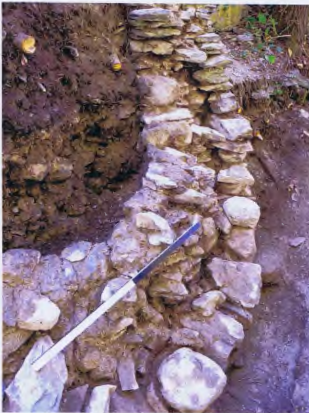
Abb 88 Bastion an E-Aussenseite, durch ADG freigelegt. Aufsicht Halbschale
