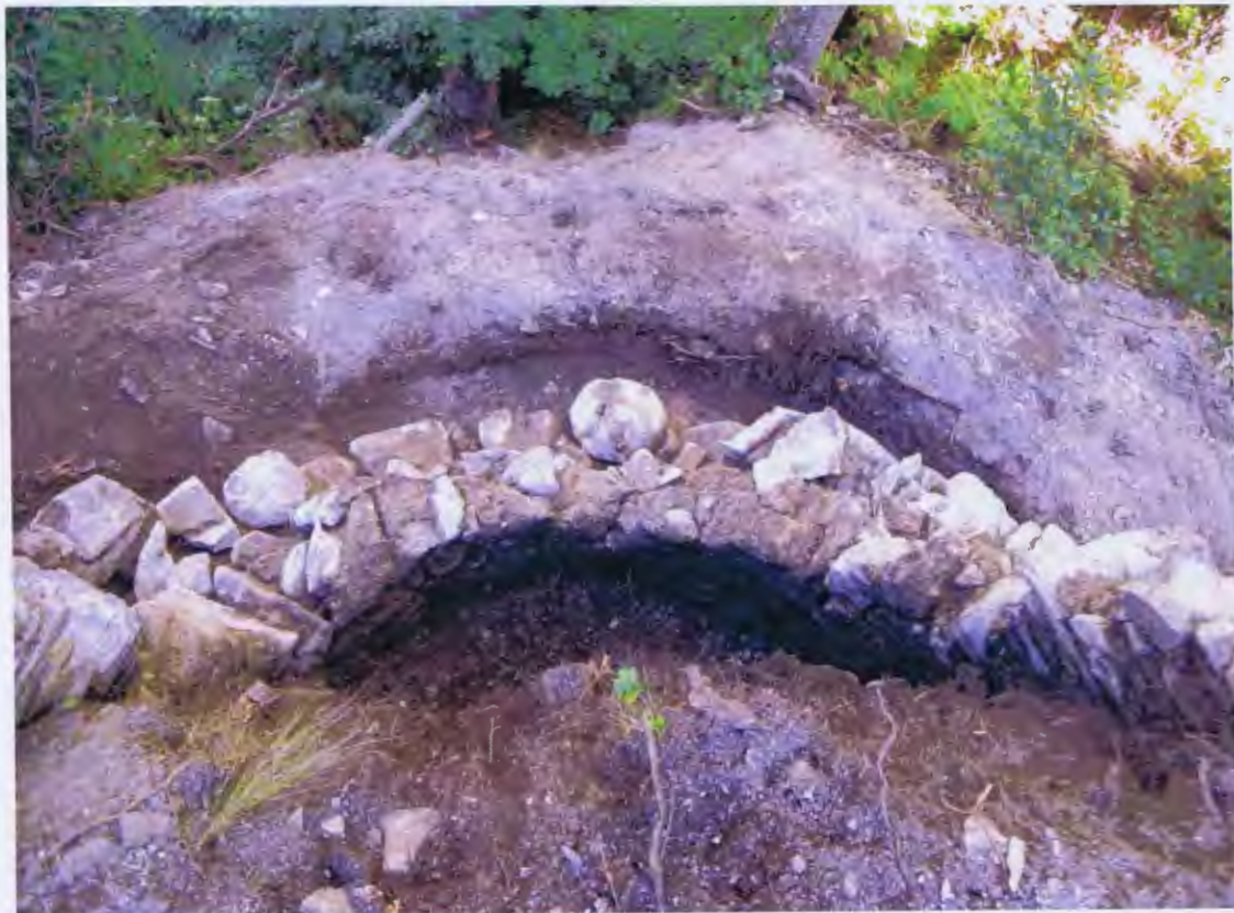
Abb 86 Bastion an E-Aussenseite, durch ADG freigelegt.
