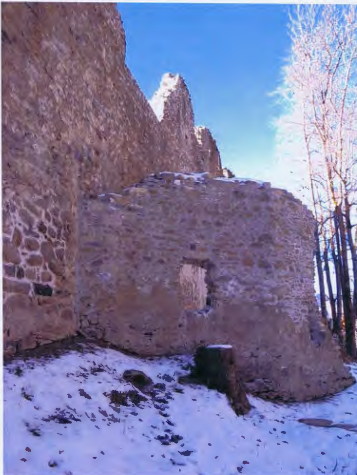
Abb 92 Nachzustand 2013. Zwingermauer an Nordaussenseite, Ansicht aussen
