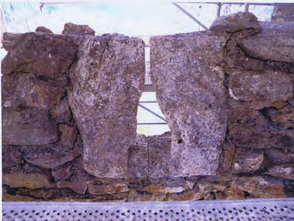
Abb 100 Umfassungsmauer Nord, Brüstungsmauer mit Schlüssellochscharte Phase 2
