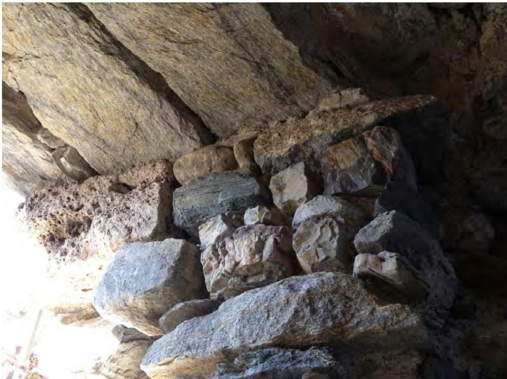
**Abb. 44** Turm 2. Geschoss, Scharte in grossem Ausbruch in der Westmauer
