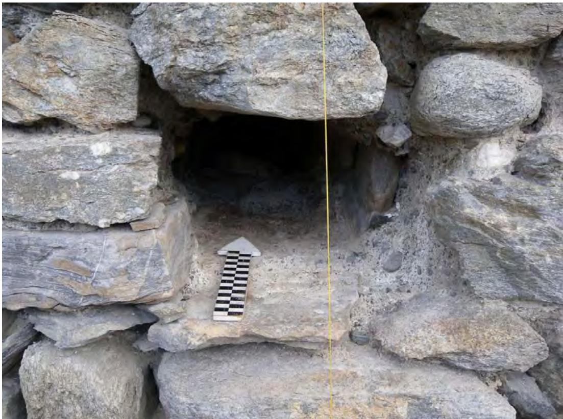
**Abb. 48** Negativ Kragbalken zu Podest Treppe an der Südfassade, von Süden
