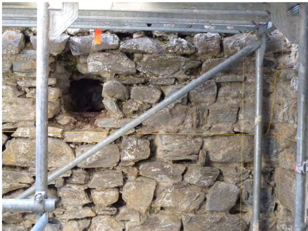
**Abb. 37** Negativ Nord-Süd-Unterzug zu Boden 3. Geschoss in Südinnenwand
