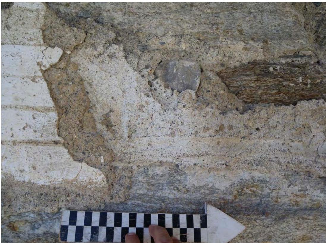
**Abb. 56** Detail Verputze an Südostecke des Turmes: rechts originaler „pietra rasa“ mit Fugenstrich, links jüngerer deckender Verputz mit eingeritzter Quaderimitation
