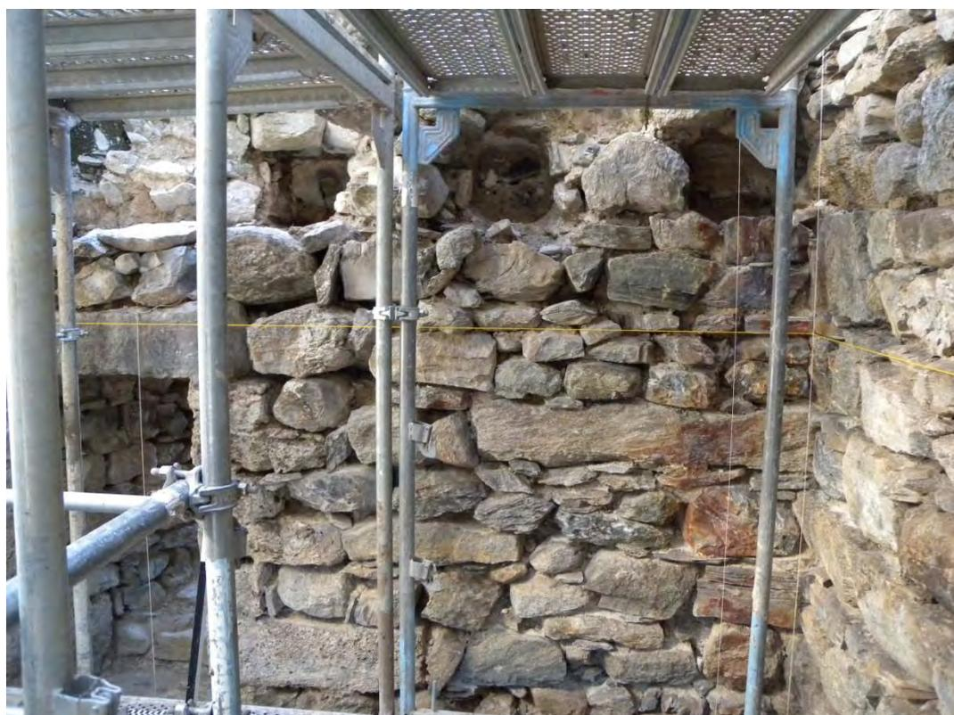
**Abb. 38** Negative zu Boden 3. Geschoss in Ost-Innenwand, von Westen
