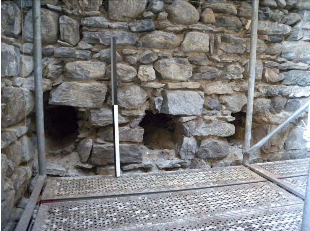
**Abb. 45** Turm, Negative Balkenlage zu Boden 2. Geschoss, in Nordwand
