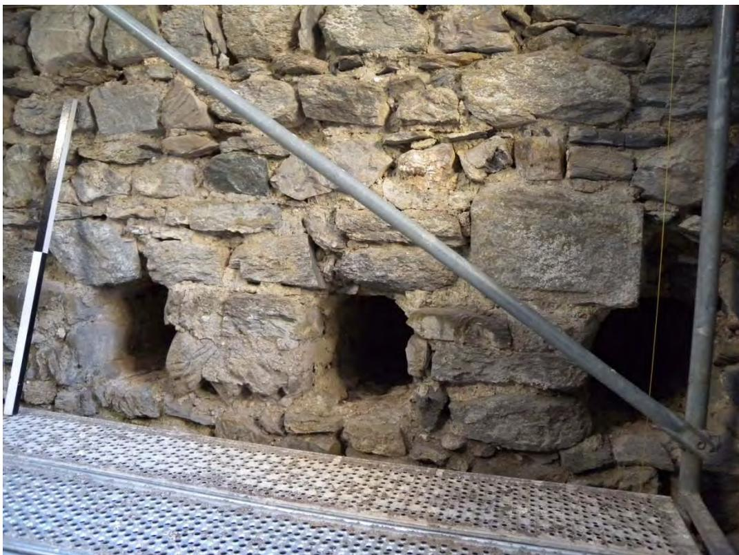
**Abb. 46** Turm, Negative Balkenlage zu Boden 2. Geschoss, in Südwand
