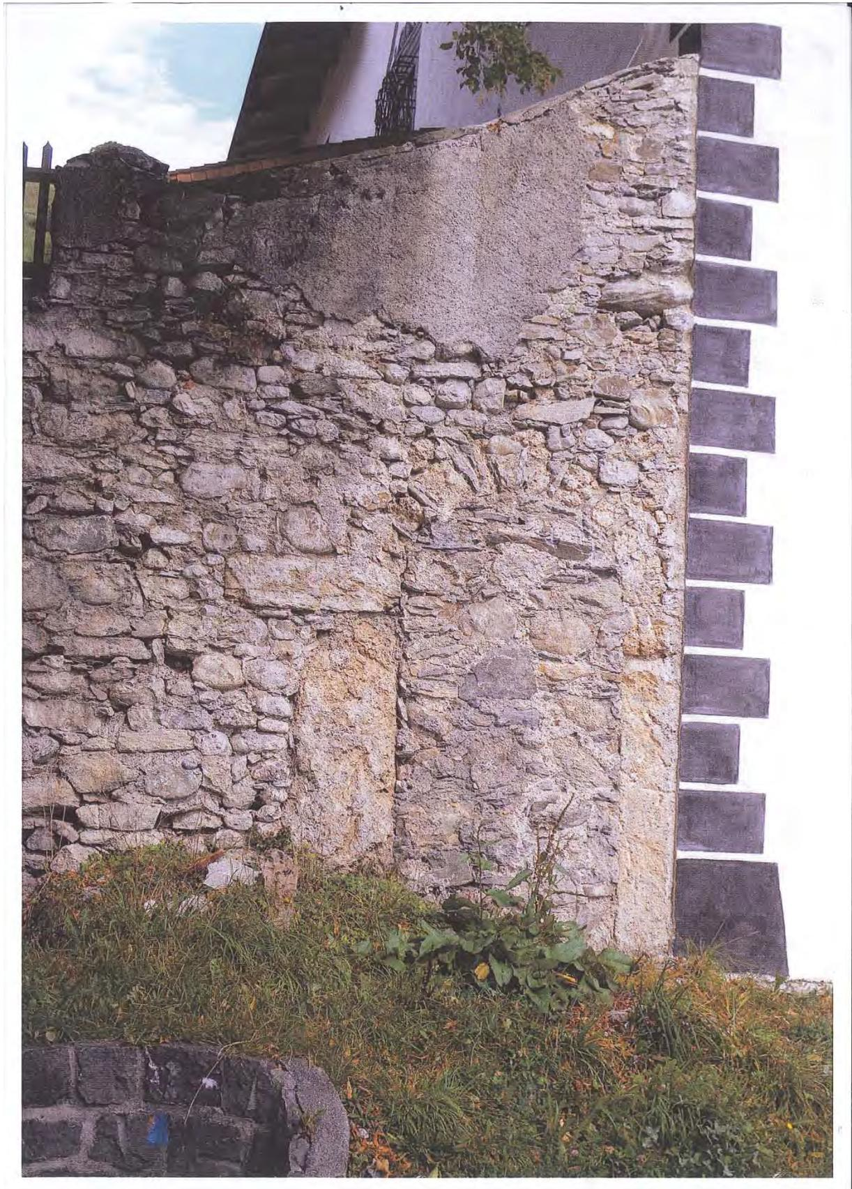
**Abb. 57** Luzein, Sprecherhaus am Landsgemeindeplatz. Zugemauertes Rundbogentor in Umfassungsmauer, evtl. Wiederverwendung Hocheingang Turm Castels.
