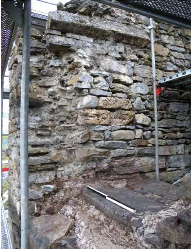
**Abb. 31** Hocheingang 3. Geschoss, westliche Leibung mit Ansatz Tuffgewölbe, von Südost
